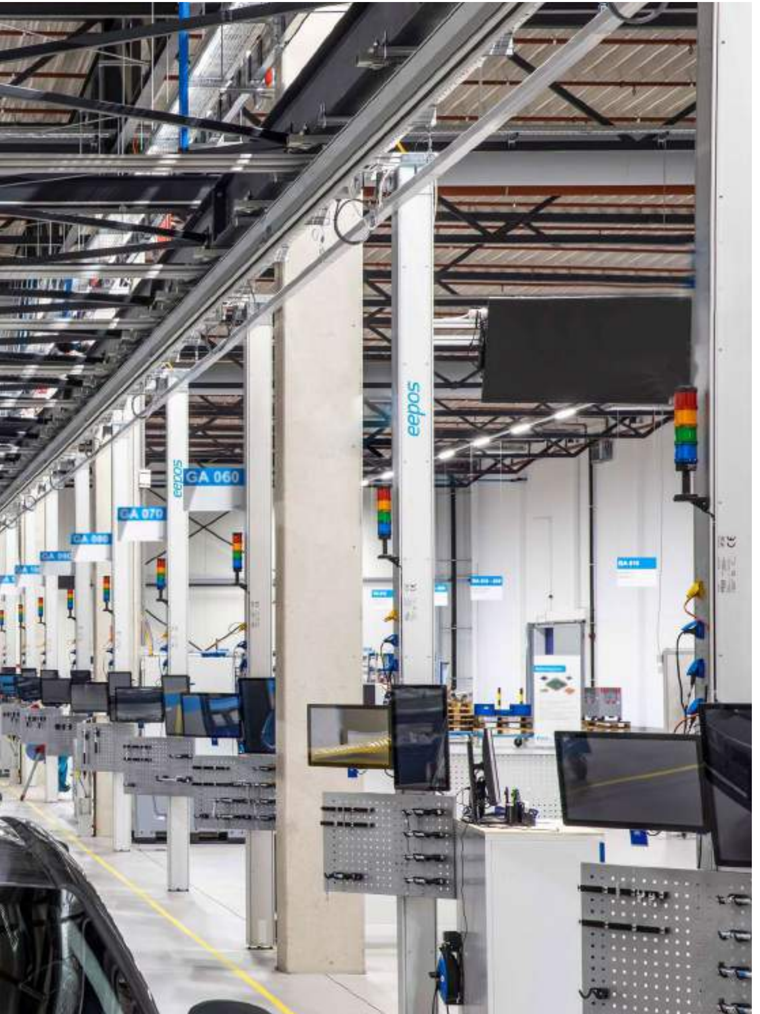
eepos Energiesäulen im Einsatz bei e.Go in Aachen eepos energy columns in use by e.Go Aachen, Germany
